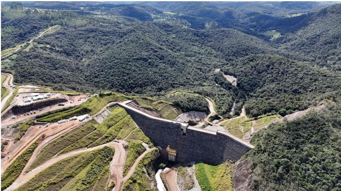
Foto 27 - Registro Fotográfico por drone da Estrutura de Contenção de Rejeito (ECJ) de rio dos porcos, construída pela Vale para conter rejeitos de mineração em caso de rompimento das barragens Forquilhas I, II, III, IV e Grupo, localizada em Itabirito.
